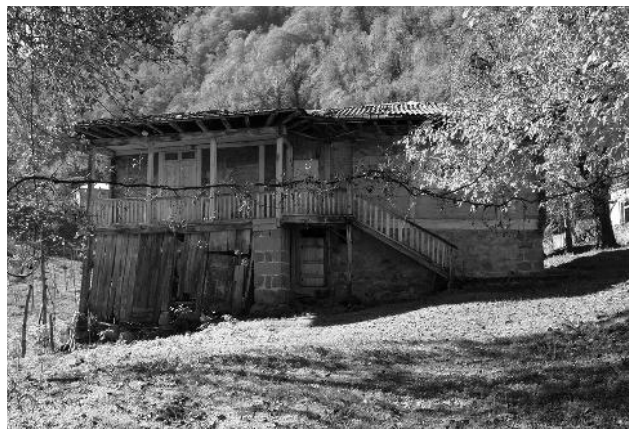
8. სოფ. ზემო ჩხუტუნეთი. ნ. კახიძის სახლი (მაჭახლის სოფლა. ხელვაჩაურის მუნიციპალიტეტი), ნ. მეფარიშვილის ფოტო
