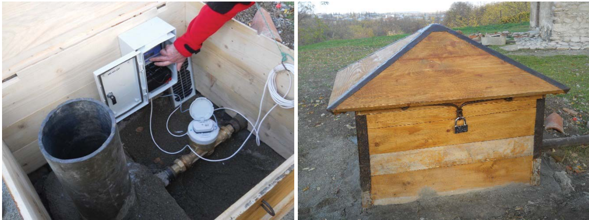
სურ.8-9. 2013 წელს, ჰიდროგეოლოგიური მონიტორინგის დაწყებისას მოწყობილი პირველი ავტომატური სადგური გურჯაანის მუნიციპალიტეტის სოფ. კალაურში
