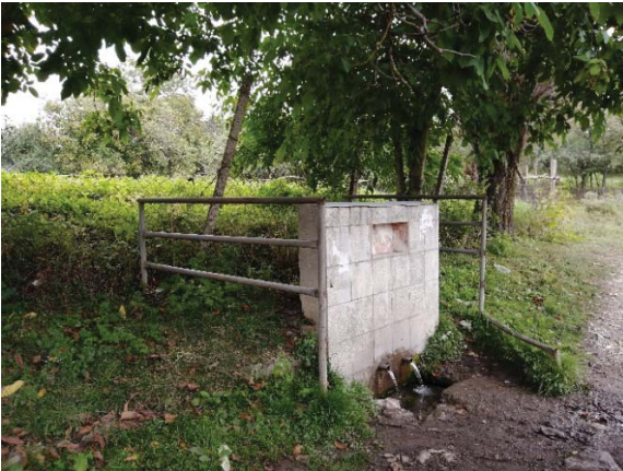
სურ.4-5. დაკაპტაჟებული წყაროები (მცხეთა-მთიანეთისა და კახეთის მხარეები)
