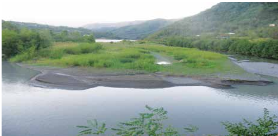
ნახ. 2.8 მოსილვის პრიზმის კაშხლისპირა ნაწილის ხელოვნური დაღრმავების შედეგად ამოღებული ნატანის აკუმულაციური კუნძული გუმათის წყალსაცავში
