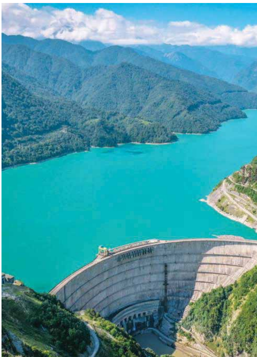
ნახ. 1.16 ჯვრის წყალსაცავი მდ. ენგურზე წყარო: https://georgiantravelguide.com/ka/enguris-jvris-tsqalsatsavi
