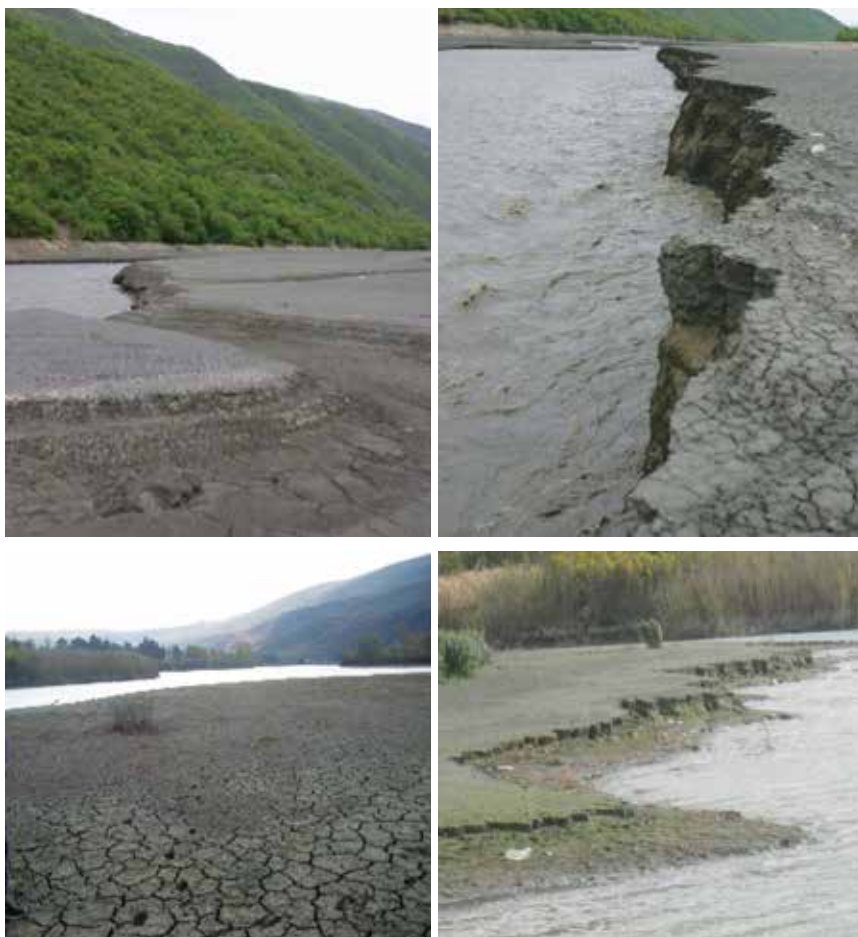
ნახ. 2.3 ჟინვალის (ზედა) და აგჯალის წყალსაცავების მოსილვის პრიზმების მდგომარეობა. 2021 წელი
