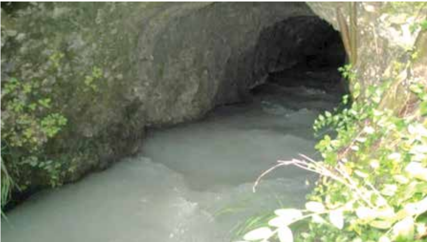
ნახ. 5.7 ენგურჰესის სადერივაციო გვირაბის აკვედუკი და ფილტრატის ყველაზე მაღალი დებიტის წყარო
