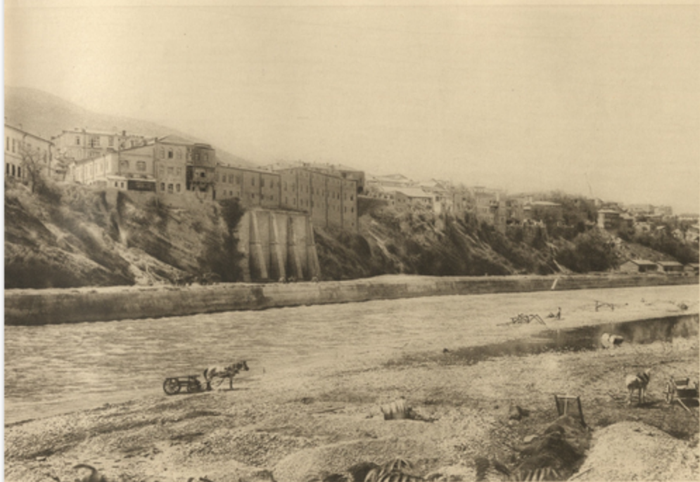
ПОДПОРНАЯ СЕНА НА КУРЕ МЕЖДУ МОСТАМИ ИМ. К. МАРКСА И ВЕРИЙ СКИМ. ПОСТРОЕНА ТИФСОТЕТОМ В 1930 ГОДУ
