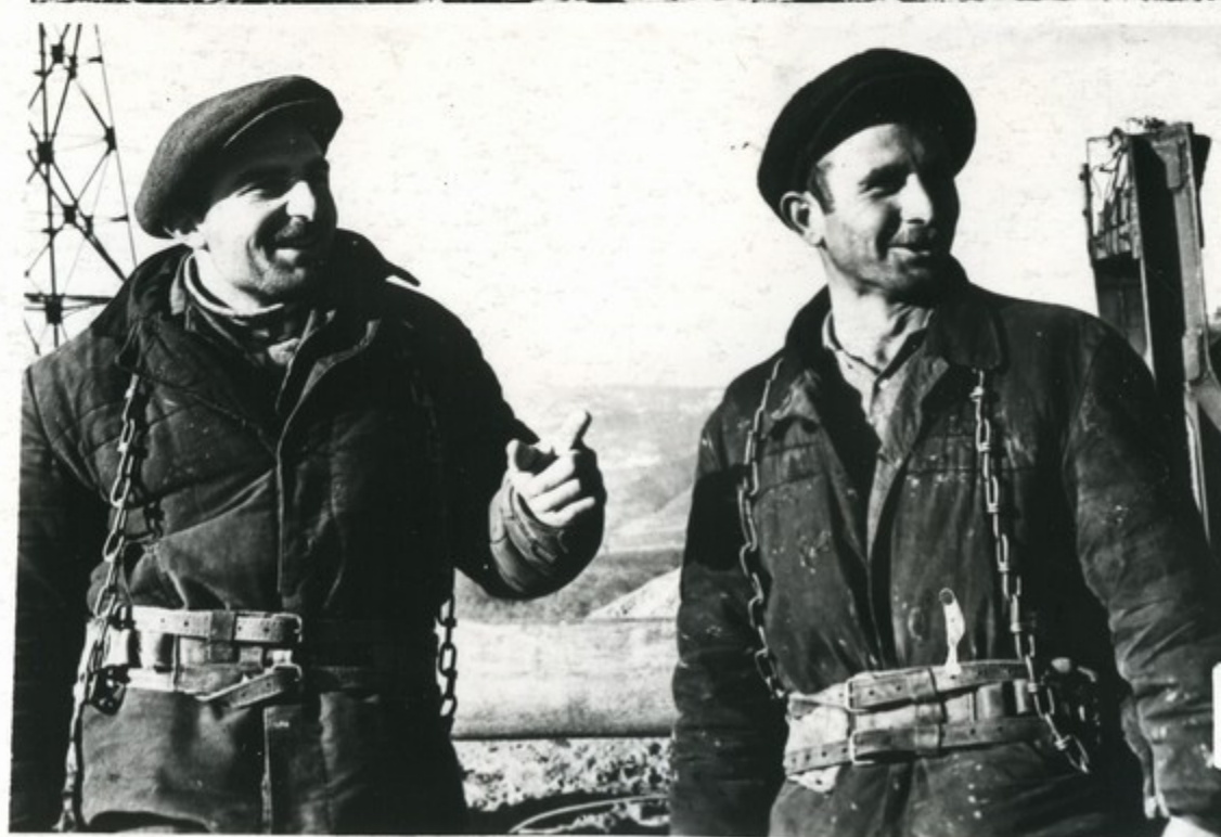
Передовые электромонтажники О. Цхададзе и Э. Датиашвили
