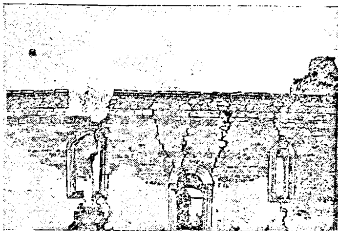
ნახ. X.3. მიწისძვრის შედეგად დანაპარალიანებული და ნაწილობრივ დანგრეული ჭეღი ეკლესიის კედელი (ფოტო ვ. ქოიავასი).
