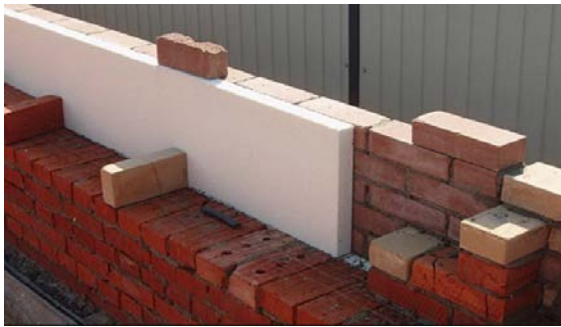
2019 წელი. კიევი. სამშრიანი კედელი პენოპოლისტიროლის იზოლაციით (EPS)
