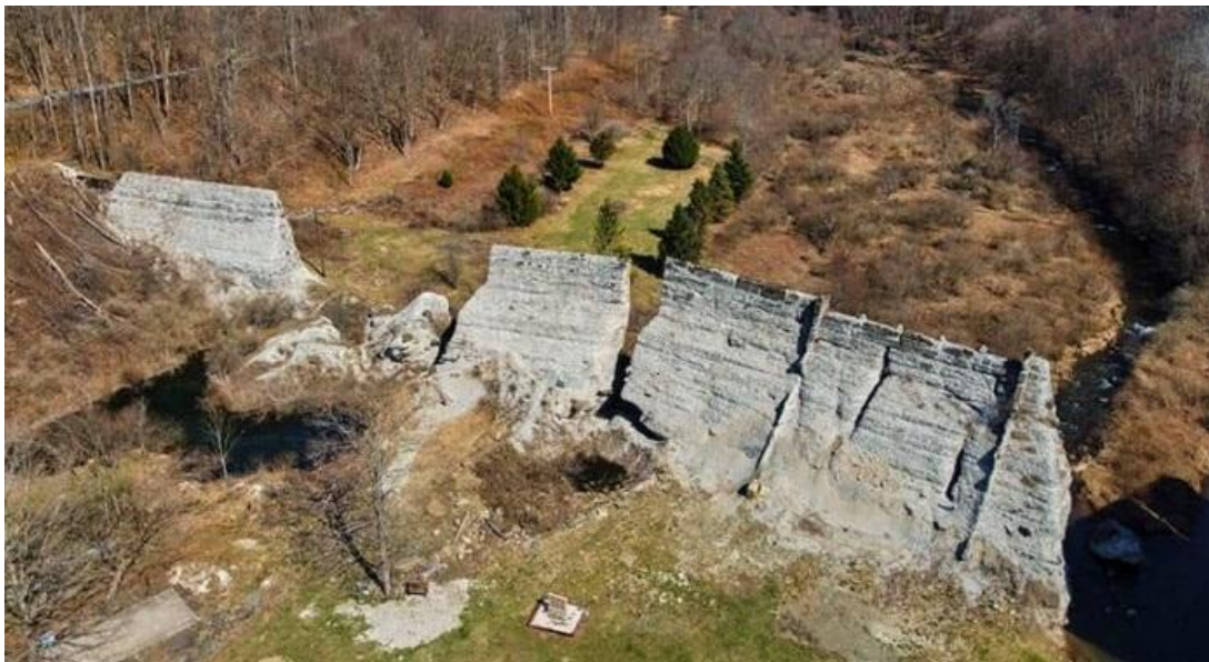
სურათი #9 - ოსტინის კაშხლის სურათი რღვევის შემდგომ
