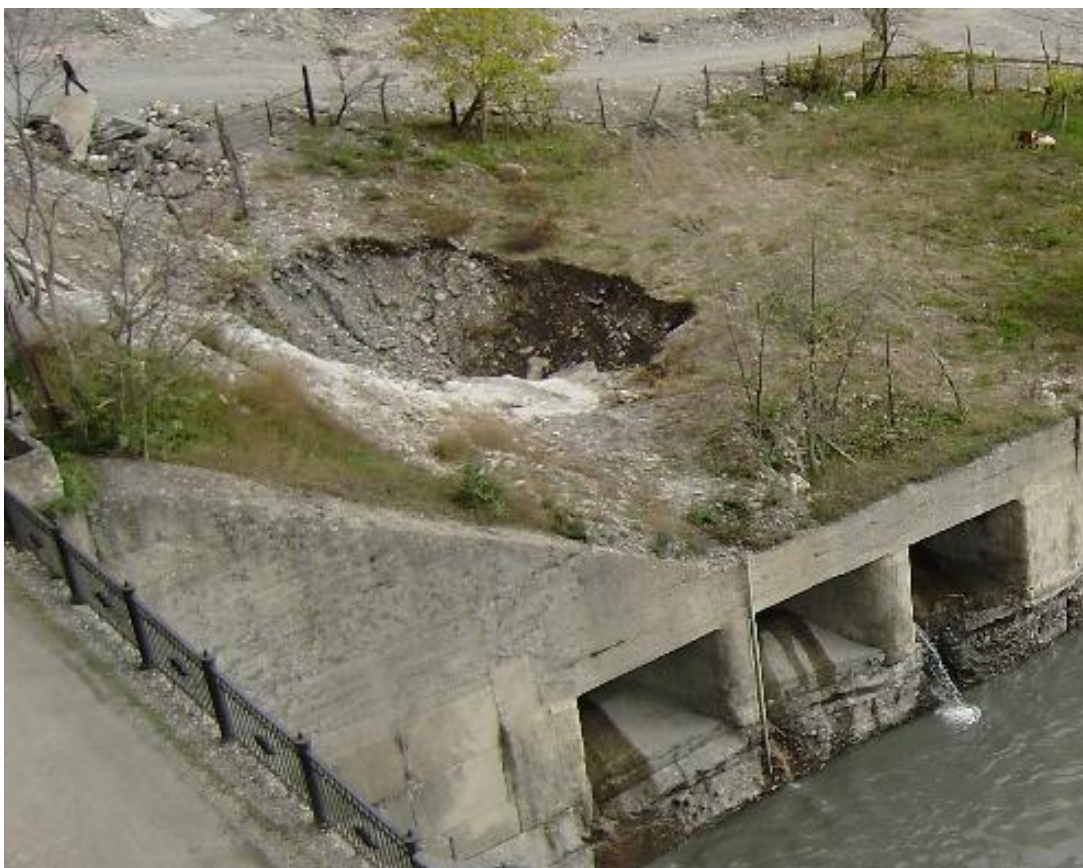
სურათი #15 - მარცხენა ფერდის მხარეს განვითარებული კარსტული სივრცე, 2010 წელი
