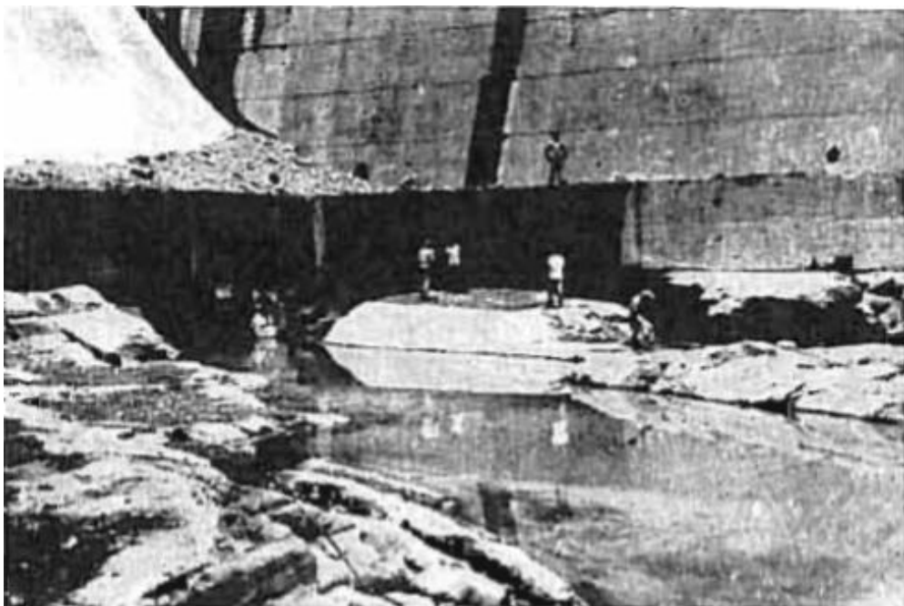
სურათი #11 - მალპასოს კაშხლის წყალსაშვის ენერჯის ჩამქრობი ჭა დაზიანების შემდგომ, 1970 წელი, მექსიკა
