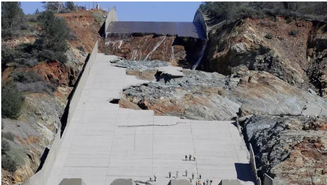
სურათი #7 - ოროვილის კაშხლის სწრაფდენის დაზიანებული უბანი, მდგომარეობა წყალდიდობის გატარების შემდგომ
