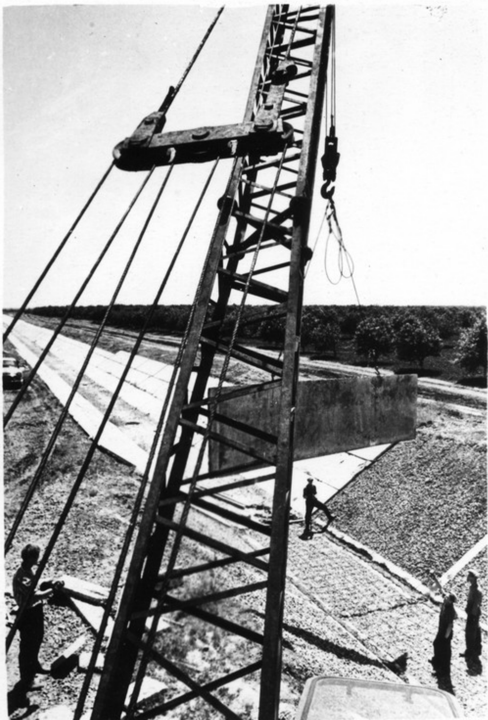
Строительство оросительной системы в Днепропетровской области.
