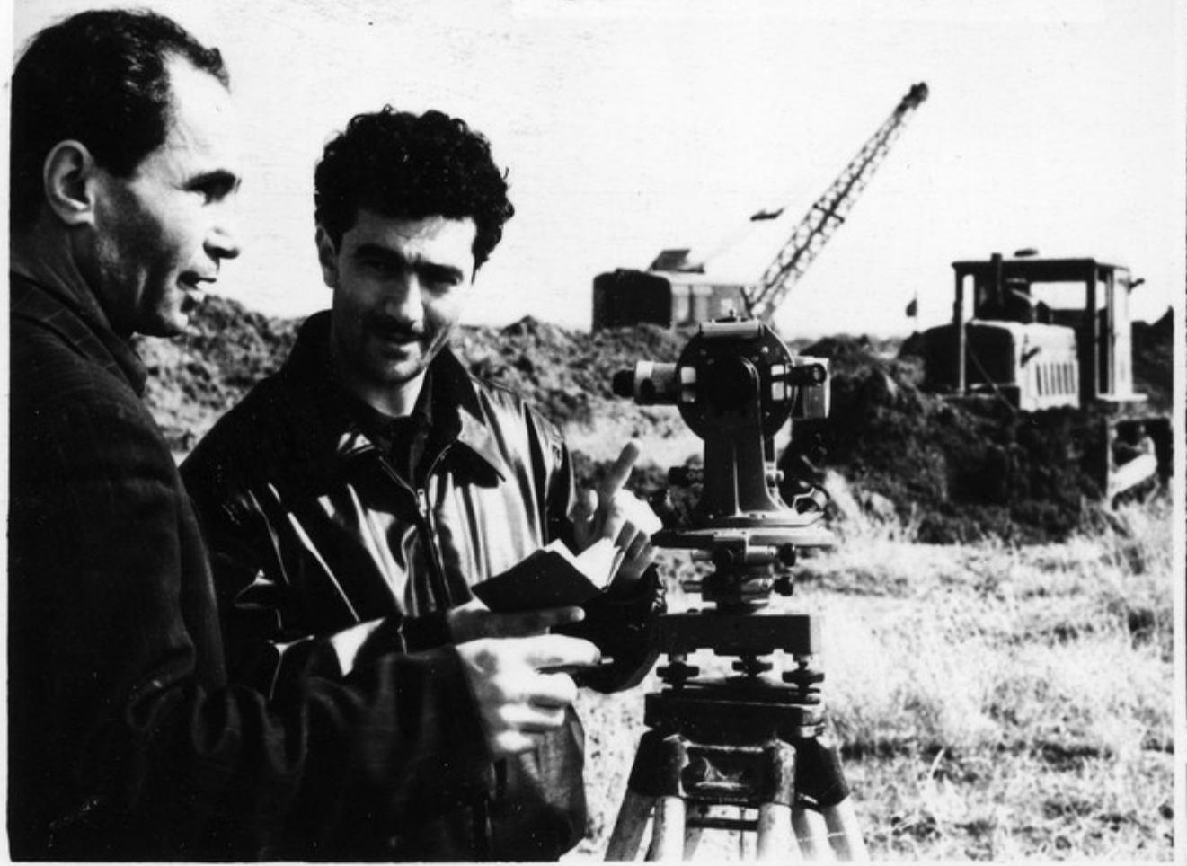
Мелиораторы Ар- мении намечают трассу дренажного канала.
