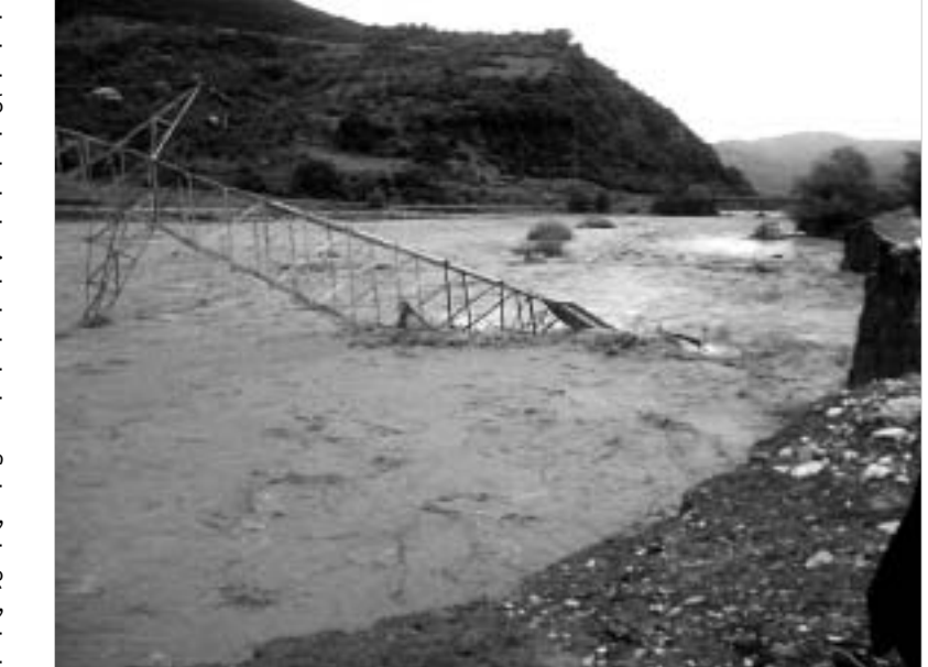
სამდლიანი გადაუღებელი წვიმების შედეგად ადიდებულმა არაგვმა ძირი გამოიწვია 110 კვ-ანი ელექტროგადამცემი ხაზის "ანაურის" 110 კვტ-იან ანძის. ანძის წაქცევის გამო ამჟამად ელექტროენერჯის გარეშე დარჩენილია ფანანავრის, გუდაურის-მღეთის და ყაზბეგის დაახლოებით 4500 აბონენტი. ენერჯიკომპანიის პრესამსახურის განცხადებით, სპეციალისტებმა უკვე დაათვალიერეს შემთხვევის ადგილი. ვინაიდან წაქცეული ანძის ადგილზე დიდი ხნის განმავლობაში ტექნიკურად მუშაობელია, მისი სხვა ადგილზე აგება გადაწყდა. "ჯეი-ი-ენი"
