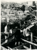
На строительстве Горьковского автозавода. 1931 год.
