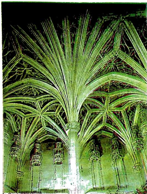
კამაროვანი გადახურვის სტრუქტურა გოთიკურ ტა- ძარში.
