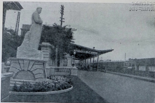
Перрон станции Гори
