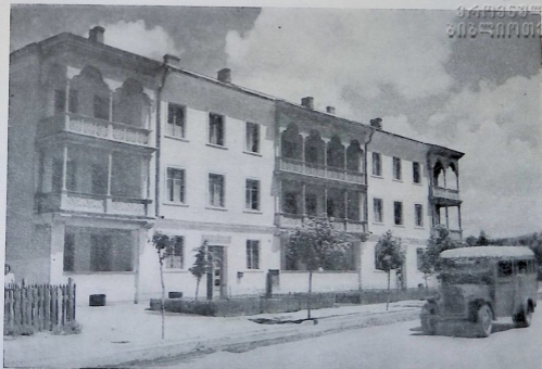
Жилой дом на улице Ильи Чавчавадзе
