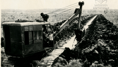
Рязанская область. На строительстве осушительных каналов в совхозе „Долгинский“.
