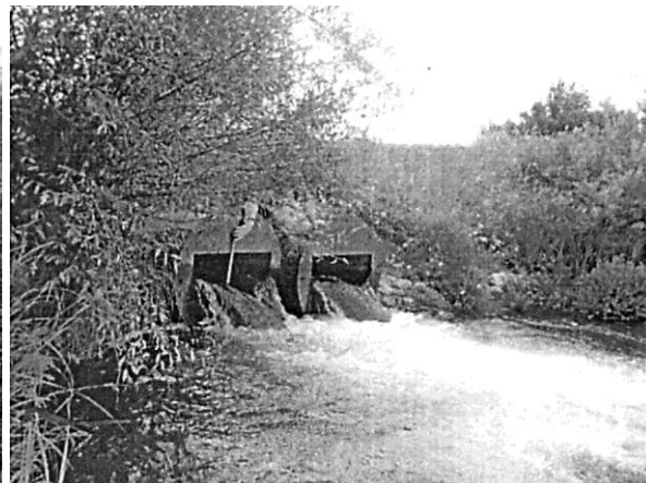
Фото I.3.3.6. Фильтрационные потоки из нижнего бьефа Шаорской каменно-набросной плотины
