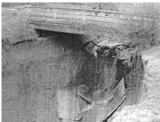
Фото I.3.3.35. Авария на водосбросе водохранилища Череми.
