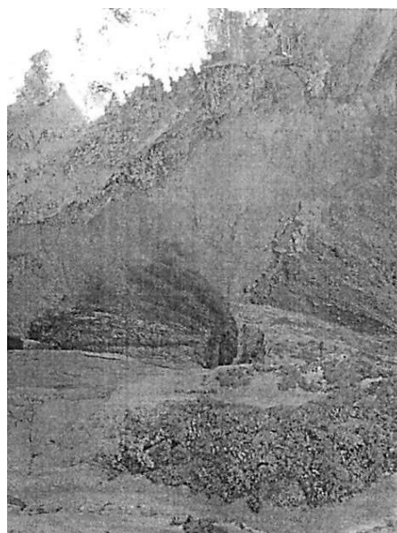
Фото I.3.3.8. Общий вид Ладжанурского водохранилища (лето 2012 года – водохранилище пустое, проводится гидравлический промыв)
