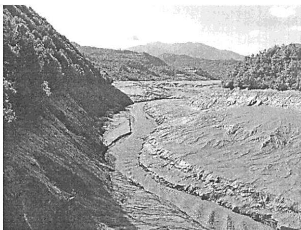
Фото I.3.3.8. Общий вид Ладжанурского водохранилища (лето 2012 года – водохранилище пустое, проводится гидравлический промыв)
