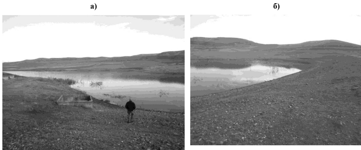
Фото I.3.3.31. а) Архашенское водохранилище; б) Плотина Архашенского водохранилища
