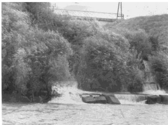
Фото I.3.3.29. Водосброс в Тбилисское водохранилище из Жинвальского водохранилища
