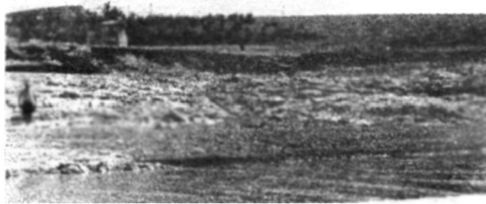
ნახ. 3.5.10. სანაპირო ფერდობების აბრაზია თბილისისა (ა) და ხრამის (ბ) წყალსაცავებზე, წყლის დონის დაწვევისას მკვდარი ჰორიზონტის ნიშნულამდე
