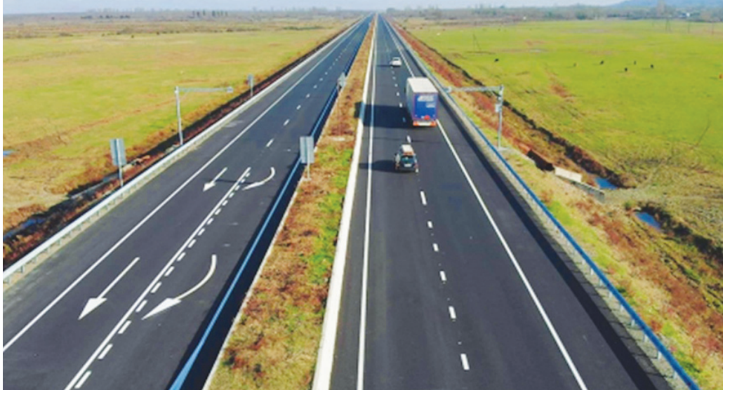
სამუშაოები ევროპის საინვესტიციო ბანკის (EIB) მხარდაჭერით მიმდინარეობდა, რომლის ღირებულებამაც 113 მილიონი ლარი შეადგინა.
