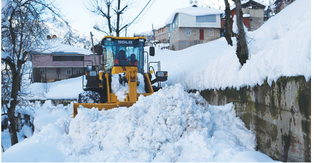
ისტების, მექანიზატორების მისამართით, რომლებიც თოვლსა და ყინვაში სამუშაოებს ასრულებდნენ, - გვითხრა ხულოს მუნიციპალიტეტის მერმა ვახტანგ ბერიძემ.
