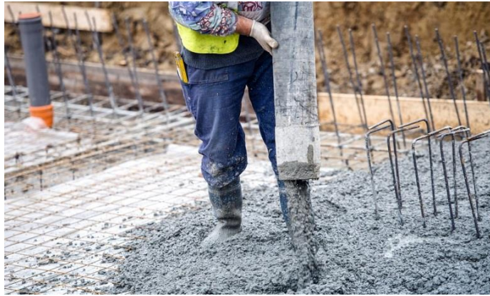
სურ. 6. ბეტონის ნარევის ჩაწყობა
