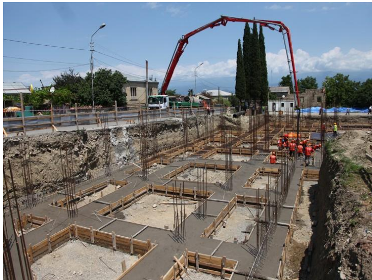
სურ. 5. ბეტონის ნარევის მიწოდება
