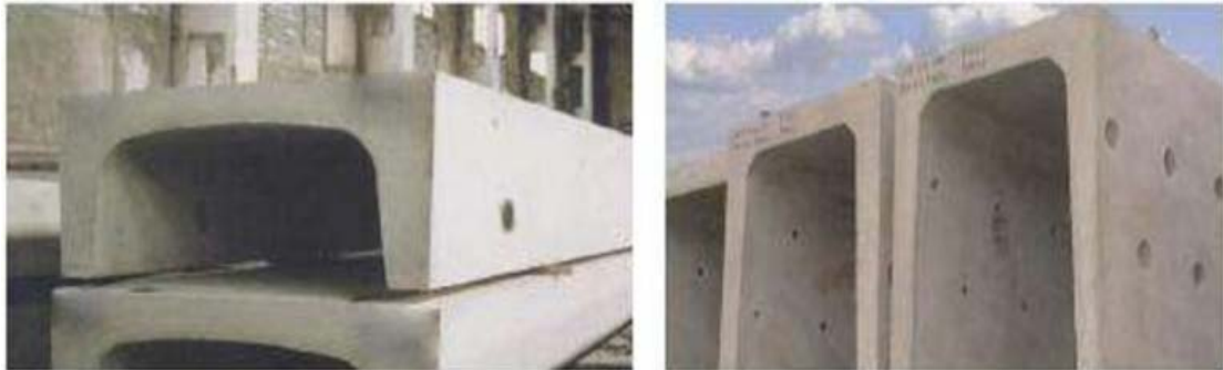
ფიგ. 7 ინვენტარული რკინაბეტონის ხიდის კონსტრუქციები
