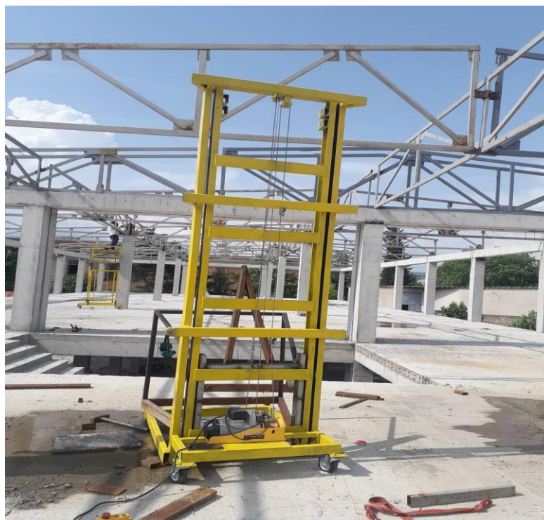
სურ. 33. ფერმების სიმაღლეზე სამონტაჟო მოწყობილობა
