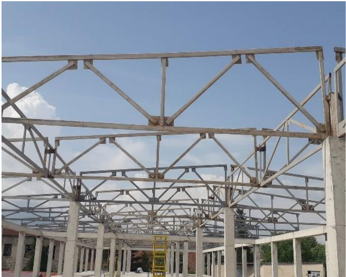
სურ. 35. სასაწყობე ფართის გადახურვის კონსტრუქცია ჩვენს მიერ დამუშავებული ტექნოლოგიით
