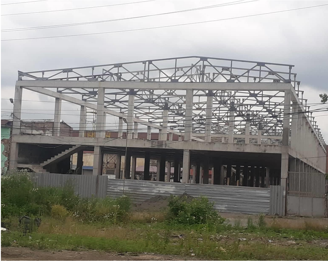
სურ. 37. სასაწყობე ფართის გადახურვის მსუბუქი კონსტრუქციის ერთიანი ხედი გამზადებული ფენილის მოსაწყობად.
