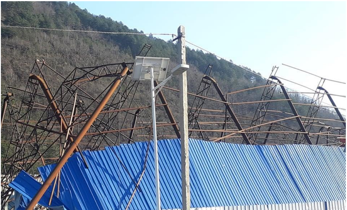
სურ. 18. არასწორად შერჩეული ფოლადის მსუბუქი თხელკედლიანი მასალით დამზადებული კონსტრუქციის რღვევა (ხარაგაულის მუნიციპალიტეტი, საქართველო)
