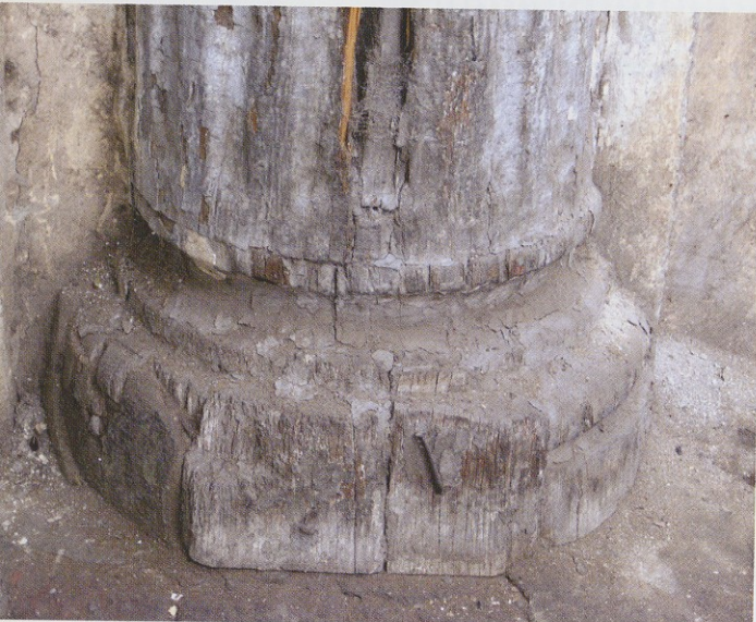
თბილისი. საცხოვრებელი სახლის ფასადის ფრაგმენტი — პილასტრის ბაზისი და პლინტი არქიტექტორი პ. შტერნი. 2006 წლის ფოტო Fragment of the façade of a residential house in Tbilisi. Base and plinth of a pilaster. Designed by P. Stern. Photo 2006
