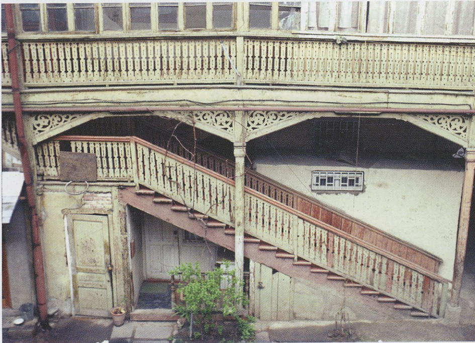
თბილისი. არქიტექტორ პაულ შტერნის საკუთარი სახლი. ეზოს ფასადის ფრაგმენტი, არქიტ. პ. შტერნი, 2000 წლის ფოტო P. Stern's house, Tbilisi. Fragment of the courtyard façade. Designed by P. Stern. Photo 2000
