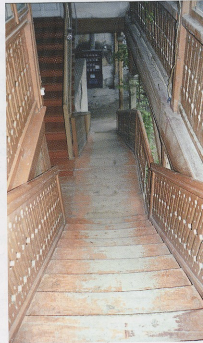
თბილისი. არქიტექტორ პაულ შტერნის საკუთარი სახლი. ხის კიბე. არქიტექტორი პ. შტერნი, 2000 წლის ფოტო P. Stern's house. Wooden staircase. Designed by P. Stern. Photo 2000
