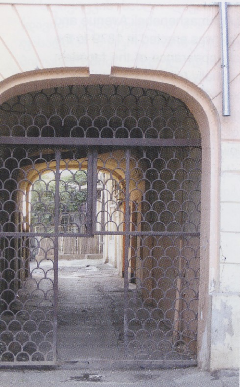
თბილისი. დავით აღმაშენებლის პროსპექტი № 81. რკინის ჭიშკარი. არქიტექტორი პ. შტერნი. 2006 წლის ფოტო Iron Gate at 81 Davit Agmashenebeli Avenue, Tbilisi. Designed by P. Stern. Photo 2006
