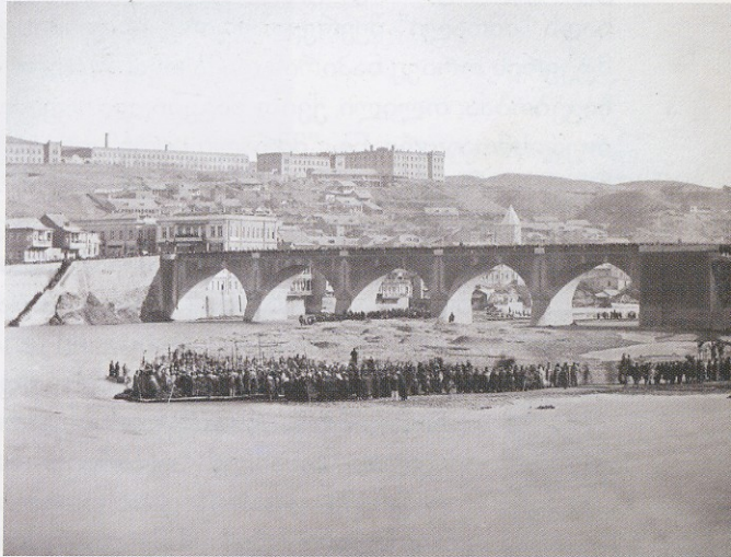
სანაპიროს ქუჩა, მიხეილის დიდი ხიდი და მტკვარი წყლის კურთხევის დღეს, 18 იანვარს. 1890-იანი წლების დასაწყისის ფოტო Mikhail's Large Bridge on January 18, Epiphany. Sanapiro Street, Tbilisi. Photo 1890s
