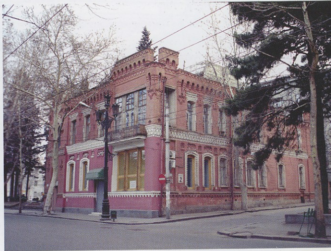
თბილისი. ბაქოს ქ. №2. საცხოვრებელი სახლი. არქიტ. პ. შტერნი, 2000 წლის ფოტო Residential house at 2 Baku Street, Tbilisi. Designed by P. Stern. Photo 2000
