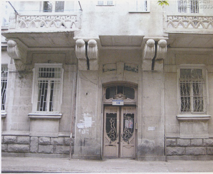
თბილისი. ი. კრილოვის ქ. № 10. საცხოვრებელი სახლი. ფასადის ფრაგმენტი. არქიტექტორი ი. დიტმანი. 2006 წლის ფოტო Residential house at 10 Krilov Street. Fragment of a facade. Designed by J. Ditsmann. Photo 2006
