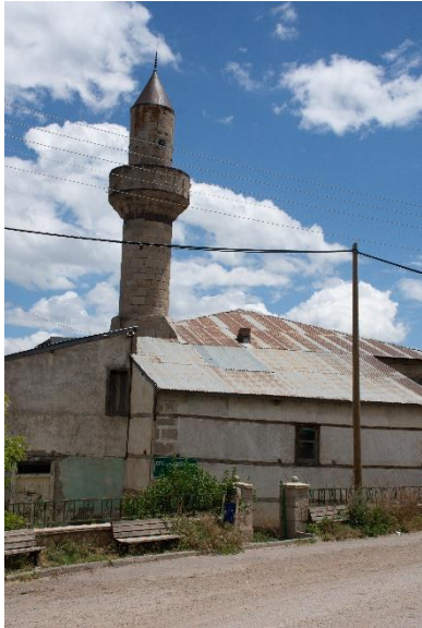
ფოტო 1. ჯამეს საერთო ხედი
