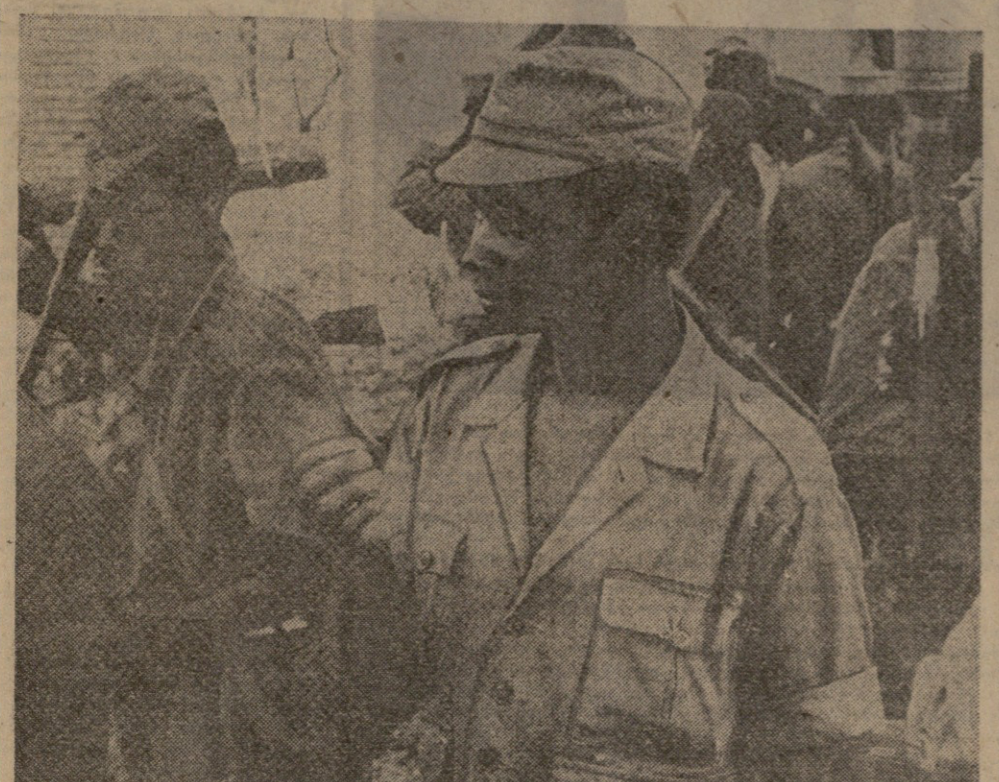
3 მანძის (ბნალ) განათავსებულია არამა, გვივის დამოუკიდებლობა და მწვენი კონცხის კუნძულების აგრეთვე პარტიის ხელმძღვანელობით, აქტიური შეტევათა ბრძოლა განაგრძობს უკვე ფრანგულ, პარტიული შეტევათა განსაკუთრებით მძლავრ სახარების მხარედასახლებების.
