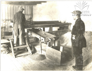
Просеивание концентратов через электро-сито.
