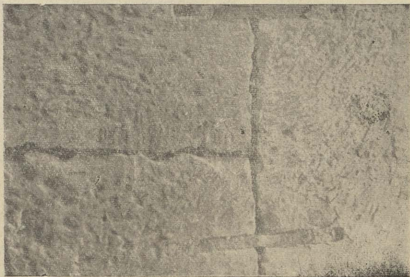
Рис. 7. Западный пилон крепостных ворот, укрепленный железными скобами--пиронами.
