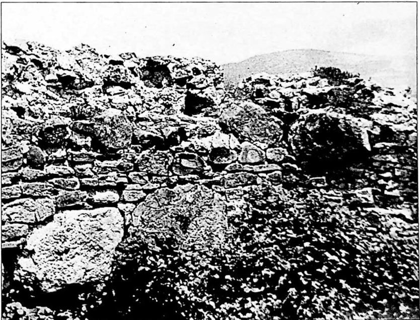
კედლის ფრაგმენტი. Фрагмент стены
