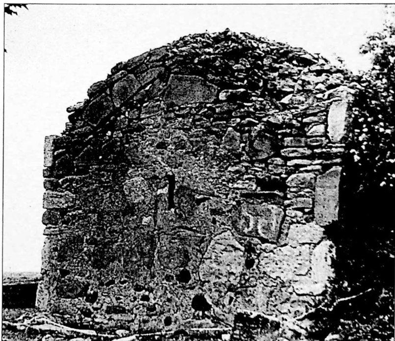
აღმოსავლეთი ფასადი. Восточный фасад
