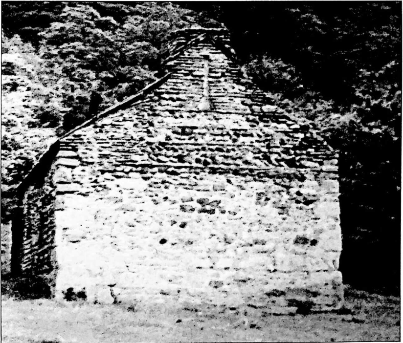
ღასავლეთი ფასადი. Западный фасад
