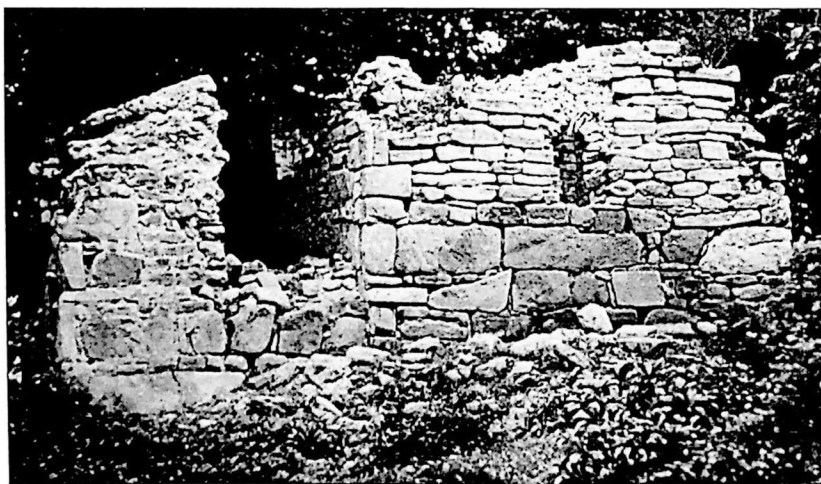
აღმოსავლეთი ფასადი. Восточный фасад
