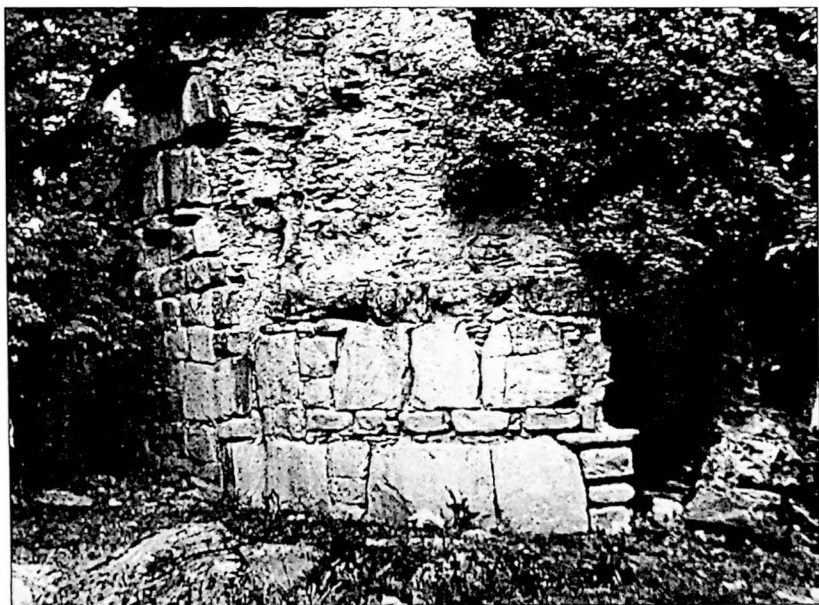
აღმოსავლეთი ფასადი. Восточный фасад
