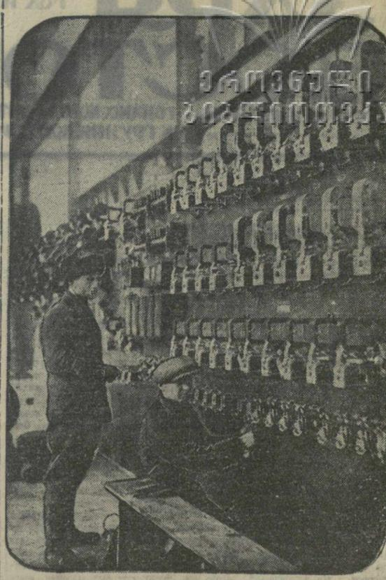
Слябин, установленный на комбинате им. Орджоникидзе (Запорожье), представляет собой щит со сложным оборудованием. Колоссажные щиты с сотнями рычагов и рубильников расположены вдоль моторного отделения слайбинга. Здесь сосредоточено управление мощными моторами, приводящими в движение слябинг. На снимке: инженер Л. Пахучий (слева) и коммутировщик Т. Новиченко проверяют контактное управление слябинга. (Фото Н. Барятинна — Совфото).
