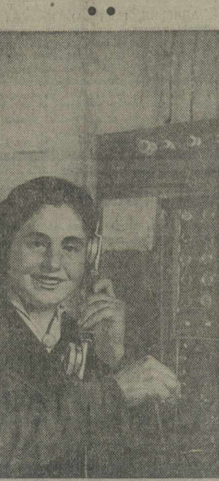
В колхоз имени Котовского, села Ободова, Винницкой области УССР, установлена телефонная связь между правлением колхоза и всеми бригадами. На снимке: колхозница-телефонистка П. Малишевская у коммутатора.
