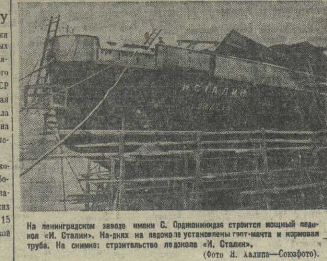
На ленинградском заводе имени С. Орджоникидзе строится мощный ледокол «И. Сталин». На днях на льдоколе установлены котлы и нормальная труба.
