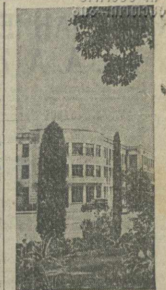
Недавно в Батуми сдана в эксплуатацию новая большая, комфортабельная оборудованная гостиница «Первомайская». На снимке: подъезд новой гостиницы. (Фото К. Альязина).
