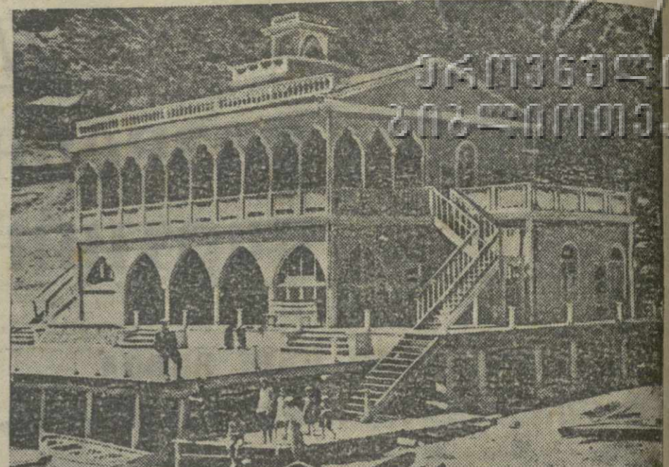
Сегодня в Мхета состоится открытие водной станции. Станция капитально отремонтирована, оборудованы комнаты отдыха, раздевалки, красной уголок. В распоряжении станции имеется до 30 лодок. На снимке: здание водной станции в Мхете.
