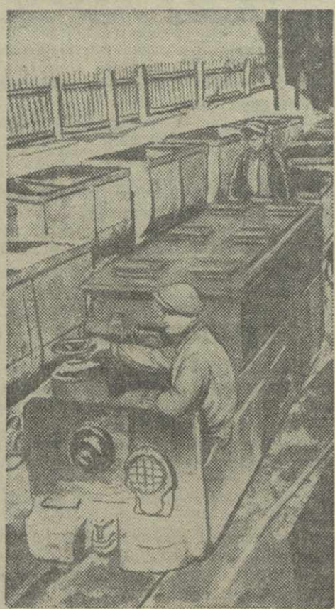
Шахта имени ЛЕНИНА треста «Тквибул-уль». Подача состава вагонов с углем на погрузочную станцию.
