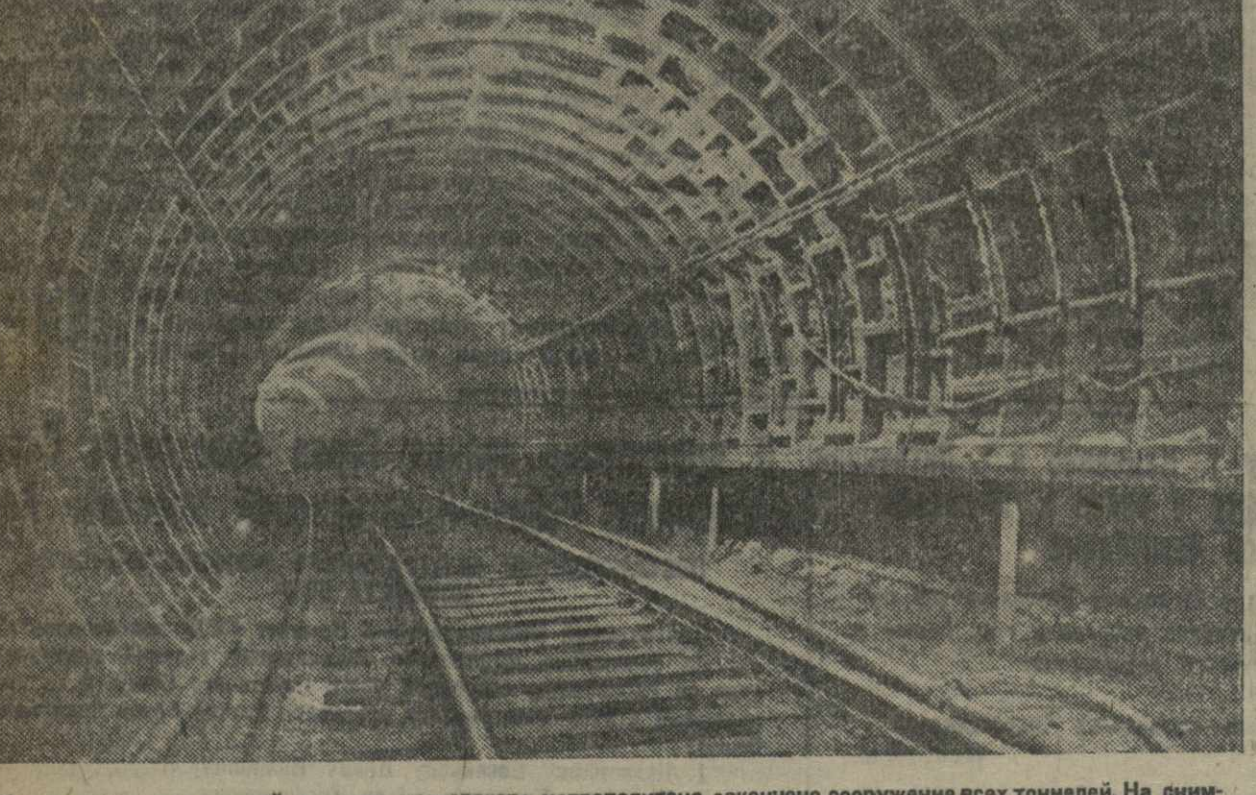
На строительстве второй очереди московского метрополитена занесено сооружение всех тоннелей. На снимке: тоннель № 81 Подпорожского района, по которому строители метрополитена обязались пустить первый поезд к 20-й годовщине Великой Октябрьской Социалистической революции.
