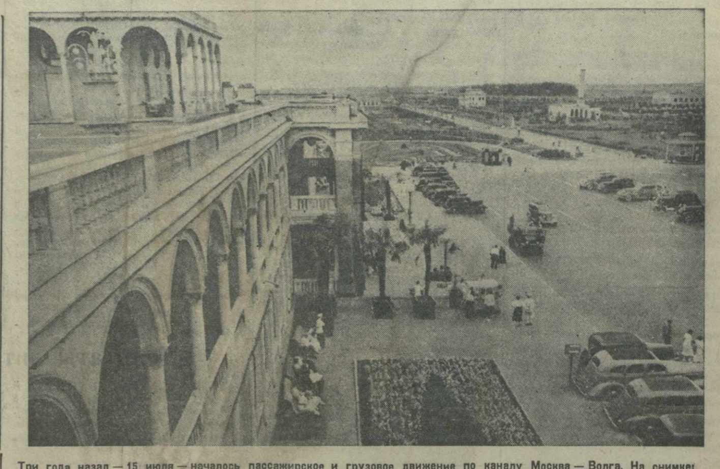
Три года назад — 15 июля — началось пассажирское и грузовое движение по каналу Москва — Волга. На снимке — под'езд и Химкинскому речному вокзалу канала в Москве. Фото М. Рупова. Фотолиния ТАСС.
