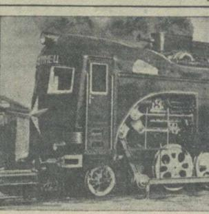
Первый советский товарный тепловоз «Сталинец» с тендер-конденсатором, имеющий комбинированный газопаровой двигатель, работающий на генераторном газе и паре. Построен Коломенским ордена Ленина машиностроительным заводом имени Кузьбашева. Фото Маныча, Фотохроника ТАСС.
