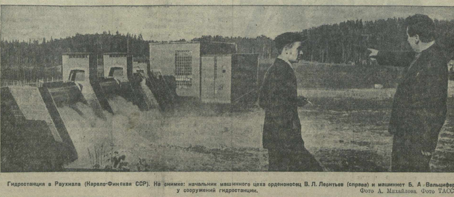
Гидростанция в Раухиала (Карело-Финская ССР). На снимке: начальник машинного цеха орденосец В. Л. Леснев (справа) и машинист Б. А. Вальцифер. Фото А. Михайлова. Фото ТАСС.
