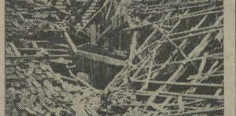
К бомбардировке Берлина английской авиацией. На снимке: жилой дом на Риттерштрассе, разрушенный в результате бомбардировки.
