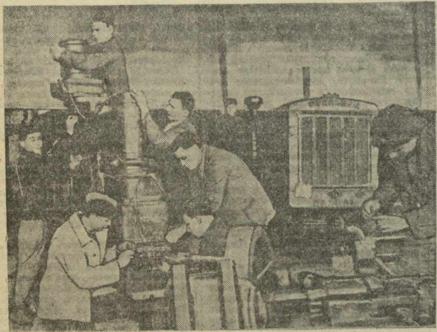
На площадке Кутаисского автомобильного завода. Бригадир ремонтно-механического цеха Михаил Марсинов со своей бригадой за монтажом станка. Фото В. Тархова.
