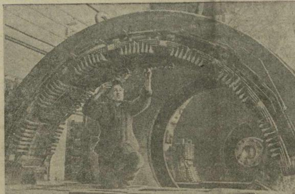
В новой сталинской пятилетке будет в основном завершено строительство Ново-Табаталынского металлургического завода на Урале. Сейчас здесь монтируется один из новых производственных объектов — блюминг. На снимке: начальник электромагистратуры блюминга орденосец П. М. Петров осматривает статор генератора блюминга. Фото Ж. Бердана. Фотохроника ТАСС.
