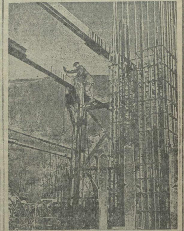
Третий участок — решающий на строительстве Храмовой гидростанции. У коллектива участка большой объем работ, главным образом по сооружению здания будущей ГЭС. Уже закончено бетонирование подземной части здания станции и проведены подготовительные работы для возведения надземного каркаса.
