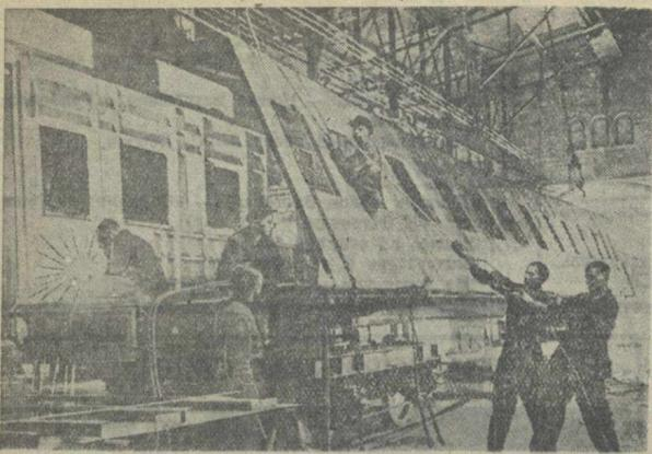
Ленинградский вагоностроительный завод имени Егорова приступил к сборке цельнометаллических пассажирских вагонов. Впервые в СССР сборка этих вагонов производится путем монтажа крупных узлов. На снимке: монтаж кузова вагона. Фото Н. Каранева. Фотохроника ТАСС.
