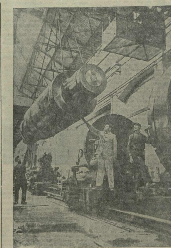
Донбасс. Ордена Ленина Ново Краматорский машиностроительный завод имени Сталина выпускает машины для восстанавливаемых заводов и шахт Юга. На снимке: установка на токарный станок проточного вала буминга, восстанавливаемого на Маневском заводе. Фото С. Нордштейна. Фотохроника ТАСС.
