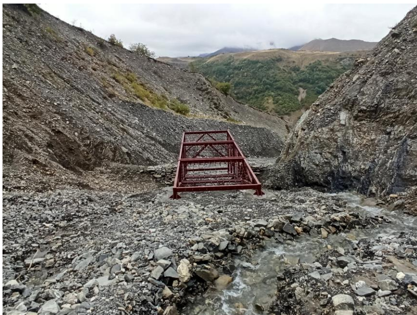
ფოტო 6.1. მდინარე მლეთის ხევის კალაპოტში აშენებული ინოვაციური ღვარცოფსარეგულაციო ელასტიკური ბარაჟის საცდელ-საექსპერიმენტო ნაგებობის კონსტრუქცია
