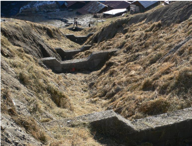
ბ) ხედი ზევიდან ქვევით ეროზიის საწინააღმდეგო ბეტონის ბარაჟები პროექტის შემსრულებლები
