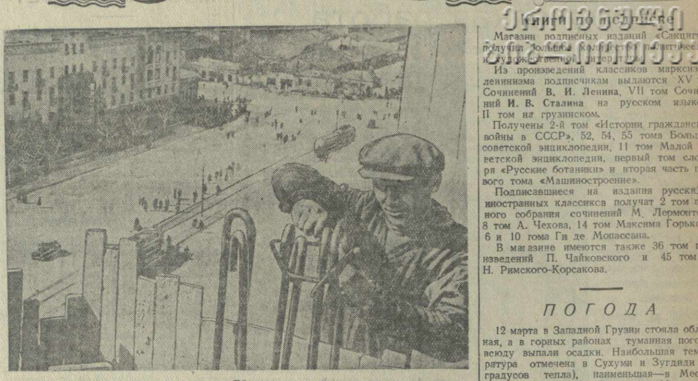
На строительстве главного фасада Тбилисского железнодорожного вокзала. Фото К. Калишевского.
