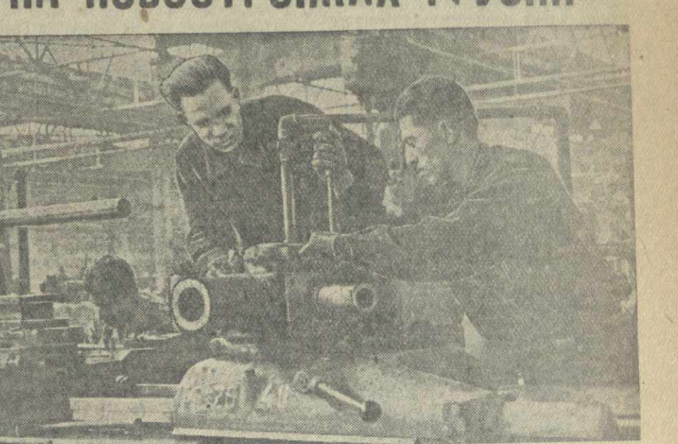
Монтаж станков в цехах главного корпуса Кутаисского автозавода.
