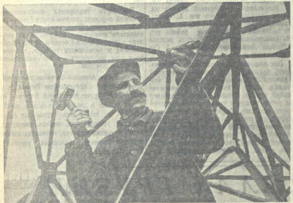
Металлические опоры линии передач для Суховской ГЭС изготавливает сейчас Тбилисский завод металлоконструкций. На снимке: сборщик конструкций Александр Кипиани, выполняющий на предмайской вахте ежедневные задания на 300—350 процентов. Фото М. Квирикашвили.
