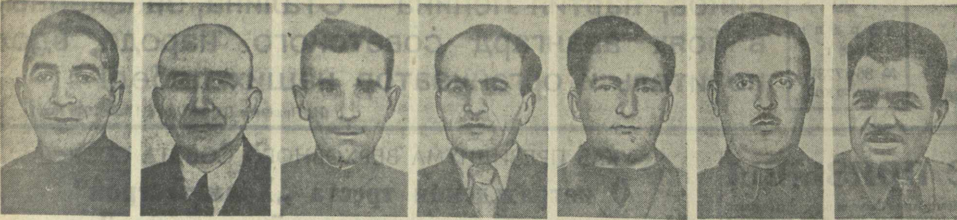
Строители Храмской ГЭС, награжденные орденами и медалями Советского Союза. На фото (слева направо): Л. Гелашвили — бригадир крепильщиков и проходчиков, Н. Махаревич — начальник тоннельного участка, И. Зибкин — бригадир арматурщиков, Е. Харитов — механик, Г. Маеский — начальник участка, Л. Таваркиладзе — старший производитель работ головного узда, В. Варашвили — заместитель начальника участка станционного узла.
