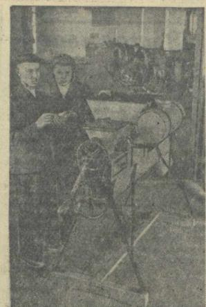
Челябинский механический завод изготовил 380 машин для протравливания семян. Новый проваиватель может обрабатывать зерно как жидким, так и сухими веществами. Его производительность — тонна зерна в час. На снимке: приемка протравителя от мастера. Фото В. Георгиева. Фотохроника ТАСС.
